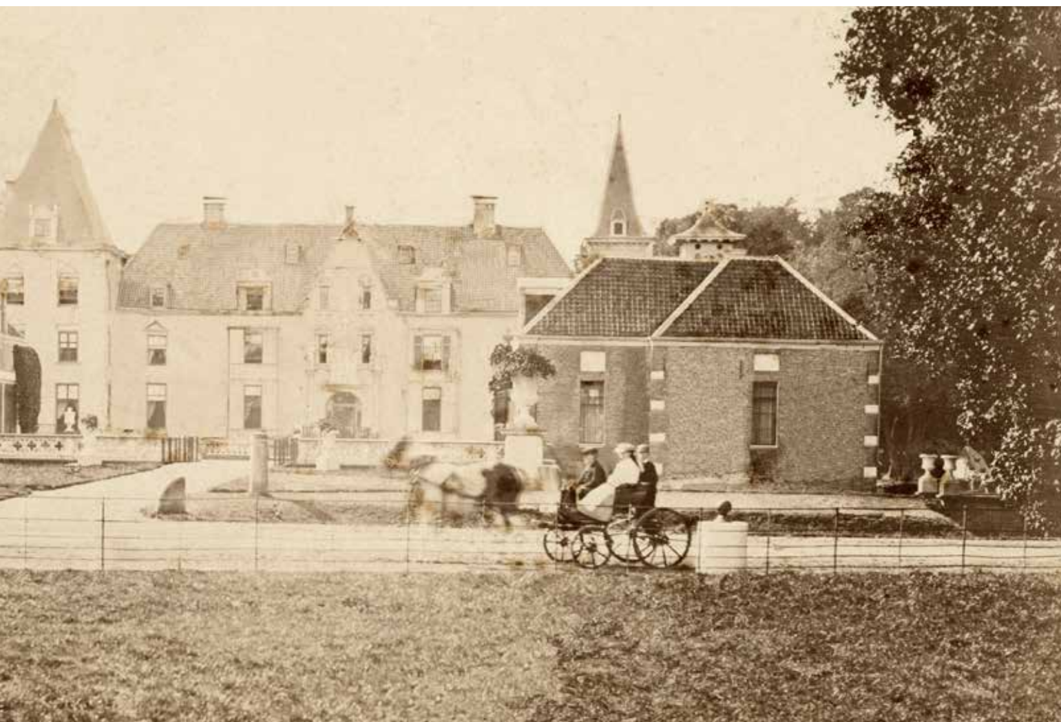
Deze foto werd gemaakt voor 1896, het jaar waarin de witte pleisterlaag van de voorgevel van het kasteel werd verwijderd. In het rijtuigje op de voorgrond, een zogeheten lady-phaeton, zitten Willem en Mechtild van Aldenburg Bentinck, de oudste kinderen van Marie van Heeckeren die op kasteel Weldam woonde. De kinderen zijn op bezoek bij hun oom Rodolphe in Delden. De baron van Twickel, herkenbaar aan zijn deerstalker (Engelse jachtpet met een klep voor en achter), loopt achter het rijtuig met de kinderen mee.
